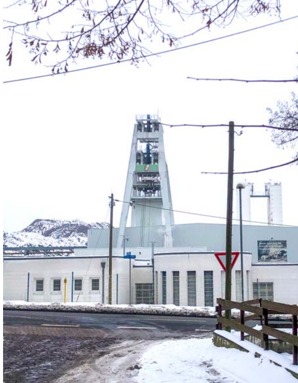
Der neue Förderturm der GTS, dahinter die Osthalle
