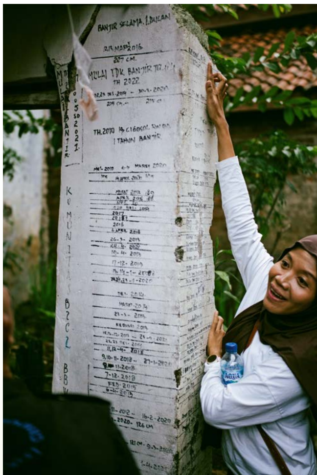
Hochwassermarke in Bandung
