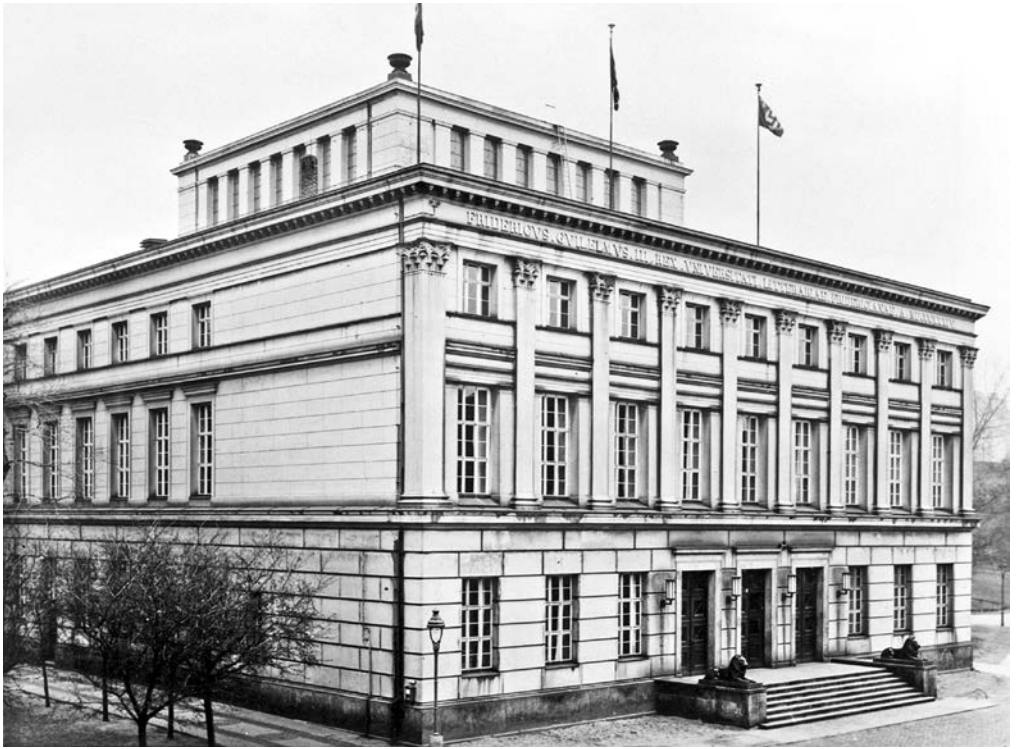
Löwengebäude (UAHW Rep. 40/III, Nr. 7 – Hauptgebäude 1933–1945)
