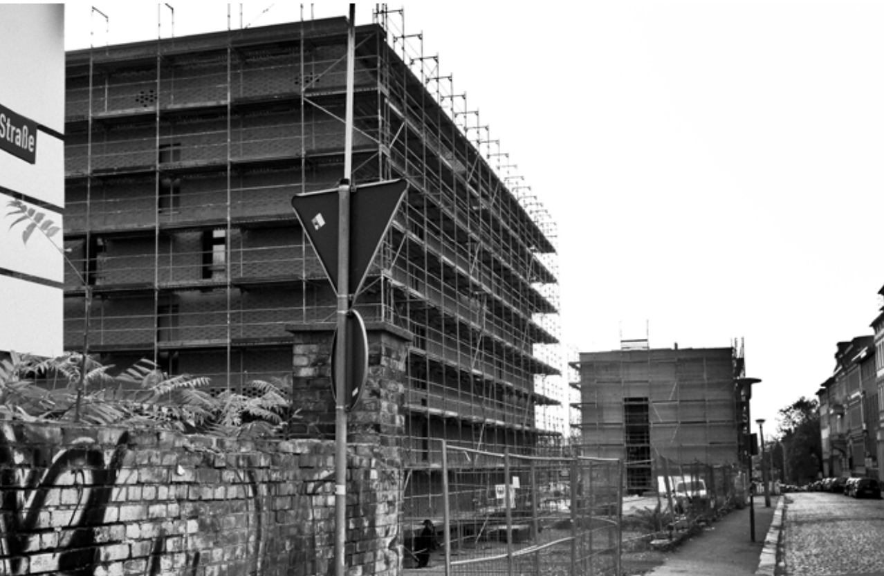
Zweckmäßige Architektur: Bibliothek und Institutsneubau am Steintorcampus
